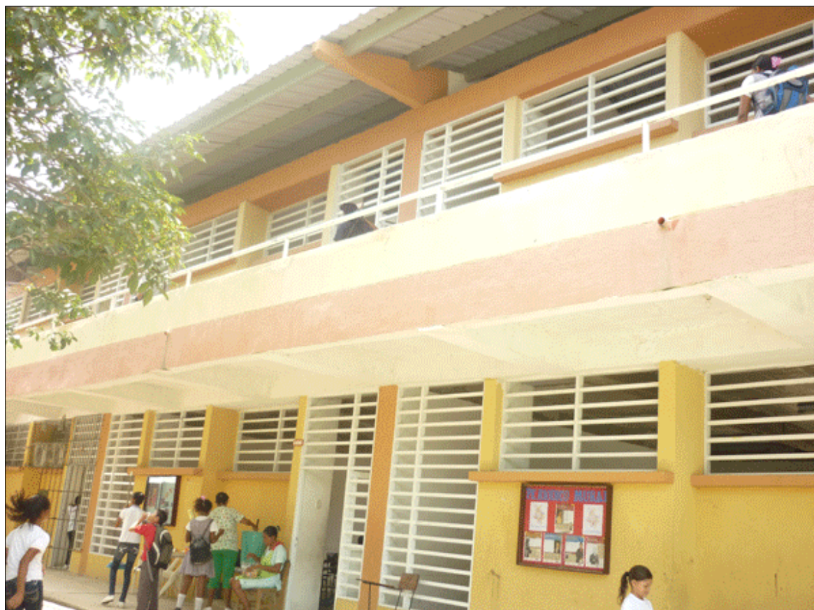
Aulas remodeladas en una de las instituciones.
